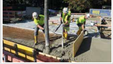
In die vorbereitete Schalung und Bewehrung der Gehwegkappe wird der Beton eingebracht (li.) und per Rüttelflasche (Mitte) verdichtet
