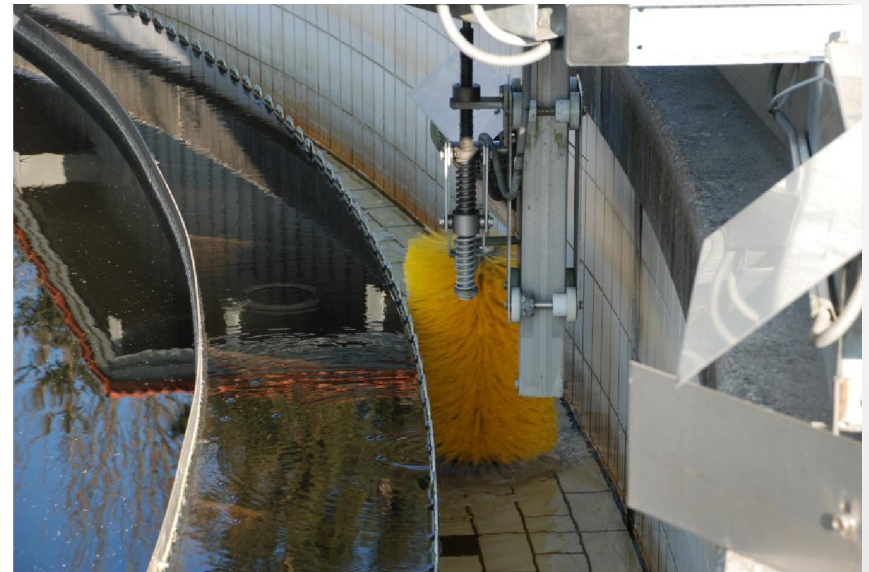
Überlauf - gereinigtes Abwasser
