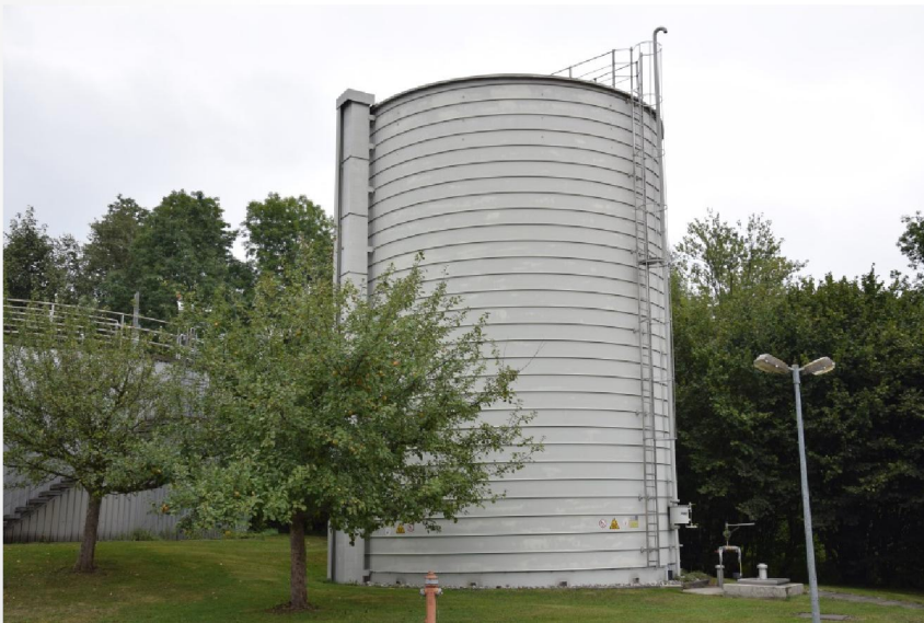
Klärgasspeicher Volumen 500 m 3
